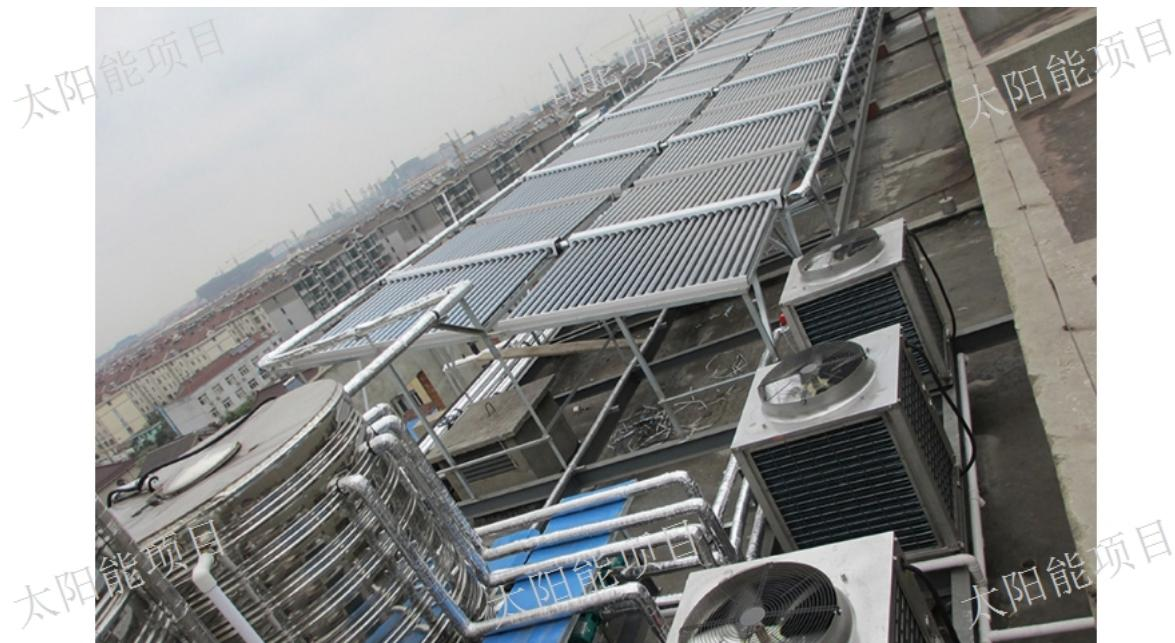
太阳能热水器是将太阳光能转化为热能的加热装置，将水从低温加热到高温，以满足人们在生活、生产中的热水使用。太阳能热水器按结构形式分为真空管式太阳能热水器和平板式太阳能热水器，主要以真空管式太阳能热水器为主，占据国内95%的市场份额。真空管式家用太阳能热水器是由集热管、储水箱及支架等相关零配件组成，把太阳能转换成热能主要依靠真空集热管，真空集热管利用热水上浮冷水下沉的原理，使水产生微循环而得到所需热水，方便了人民的生活昆山学校太阳能水箱昆山祥瑞机电设备工程有限公司是一家专业提供太阳能的公司。
